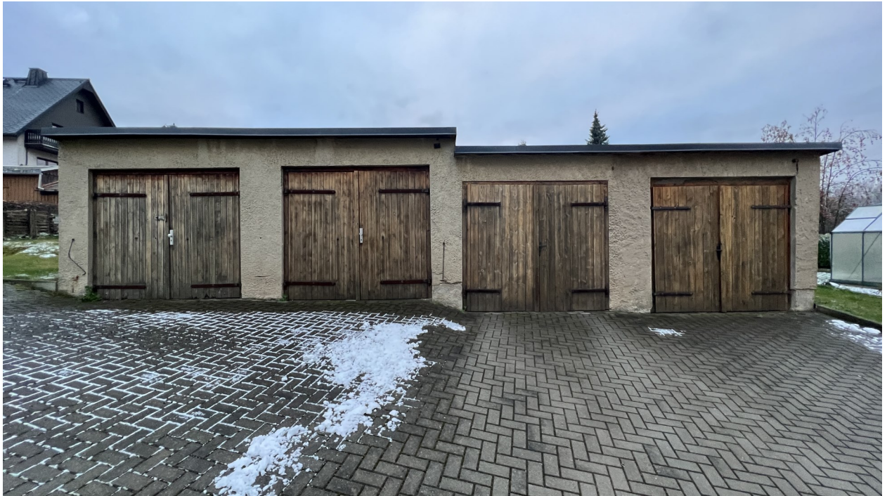
Garagen im Innenhof
