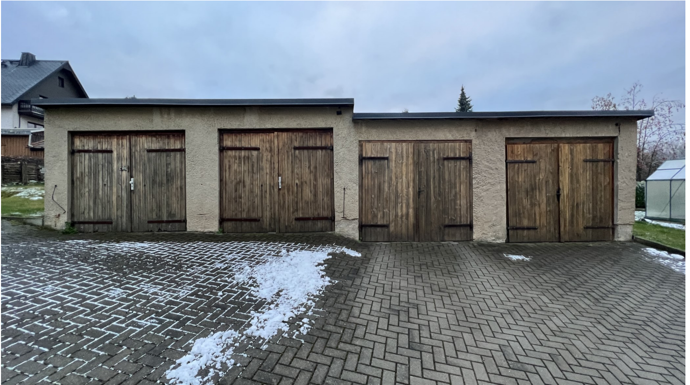
Garagen im Innenhof
